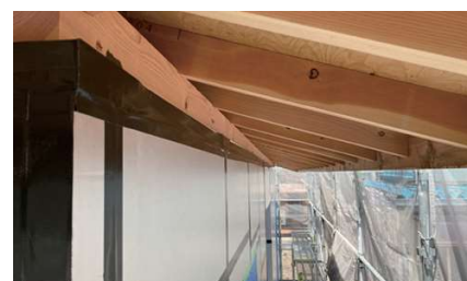
壁の外張り断熱で気密施工は容易
