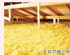
天井の施工例
