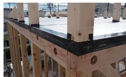
気密施工は防水気密テープで処理
